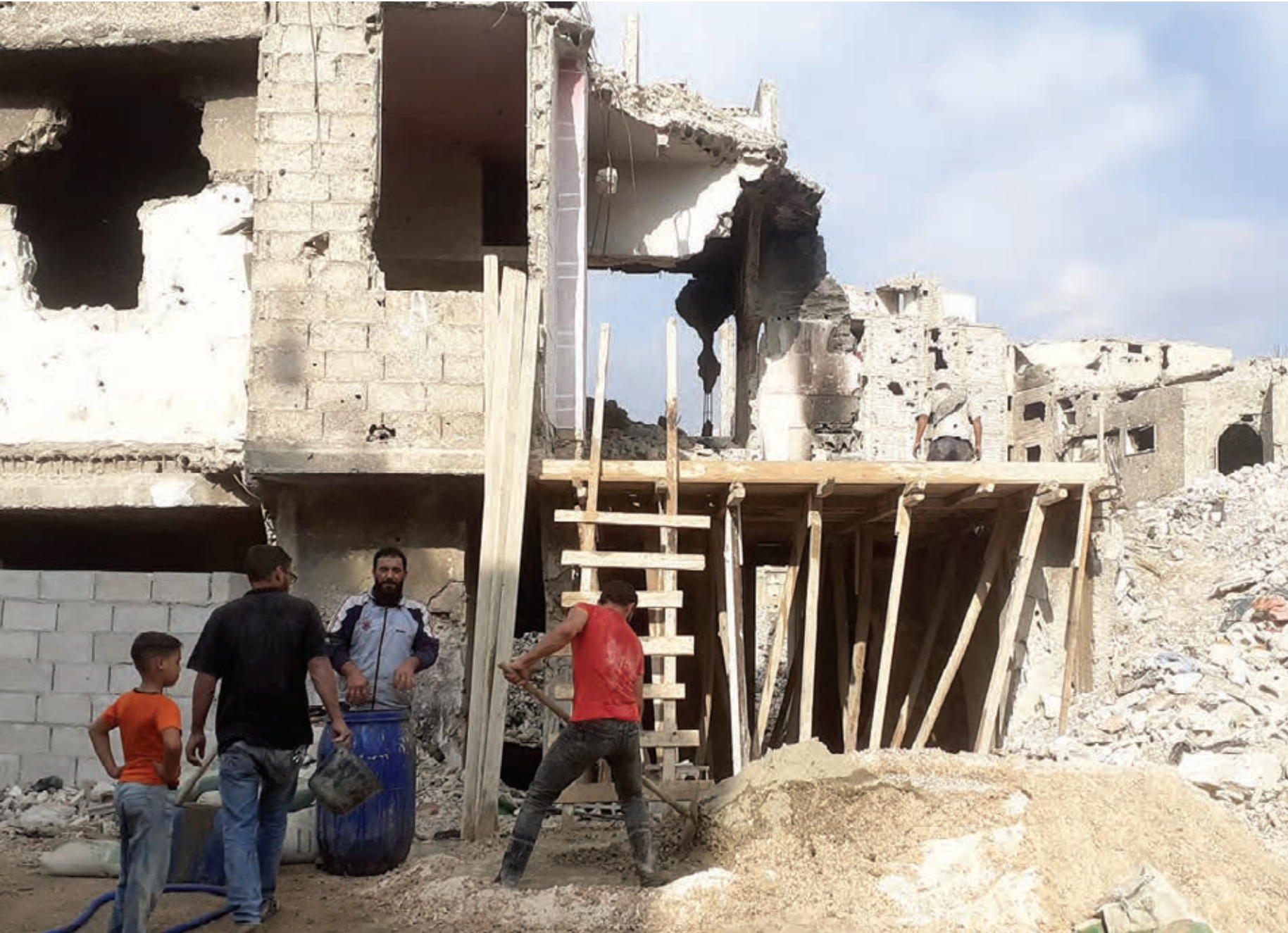
البناء والترميم بجهود ذاتية وغياب تام لأي خطة حكومية (الشرق الأوسط)
