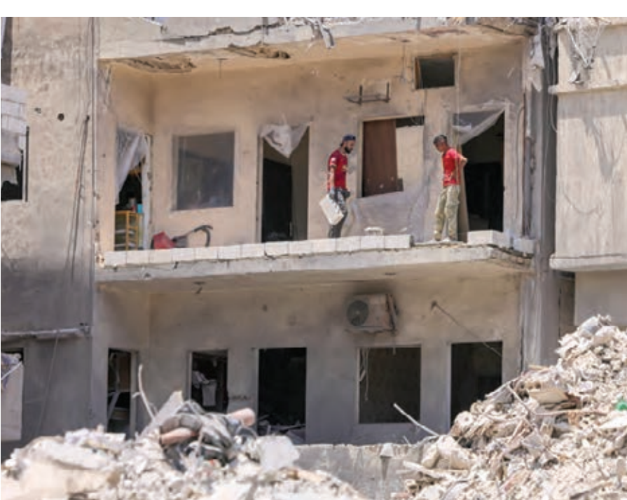
عمال بناء يرممون شرفة مبنى دمرته غارة إسرائيلية في مدينة صور (رويترز)
